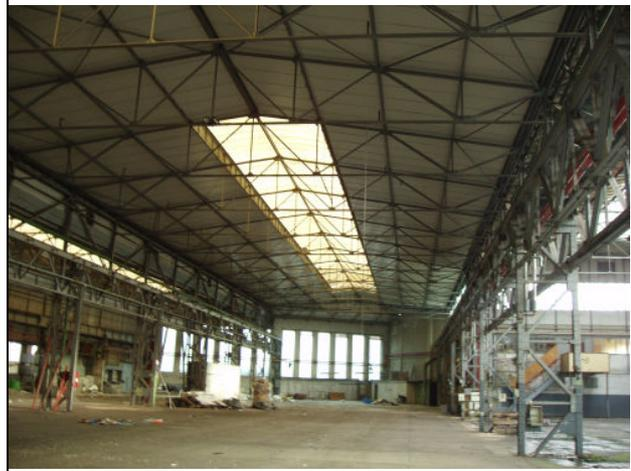
Panzerhalle: Innenansicht (offene, 2-schiffige ehem. Industriehalle mit mittlerer Stützreihe)
