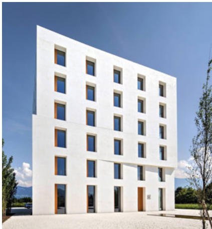
Büro und Verwaltung (Baumschlager Eberle) Lustenau (AT) 2013
