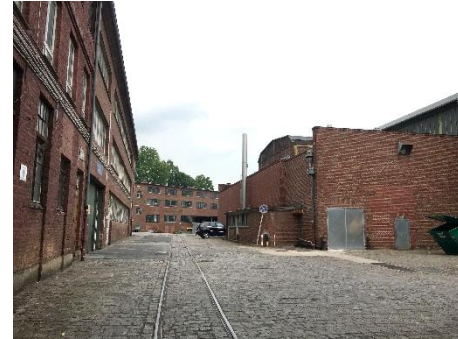
Hof mit Zugang von Egerstraße
